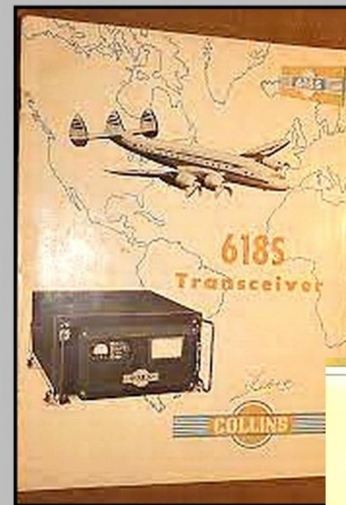
Das AVIONICS - set up für den "in flight Kurzwellenfunk" war u. a. lange Zeit durch diese Collins Transceiver 618 S ( Nachfolger 618 T ) gelöst. Der Sender lieferte 400 Watt HF Leistung, aber es war ein sehr langes Koaxialkabel und eine Kompromiss behaftete Antenne.
